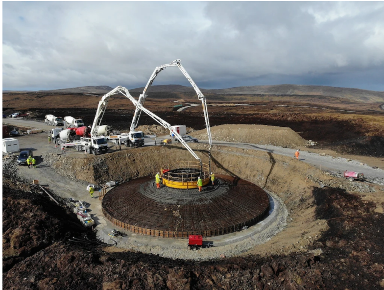
Mynd 1: Steypt undirstaða í byggingu fyrir vindraftstöð.
